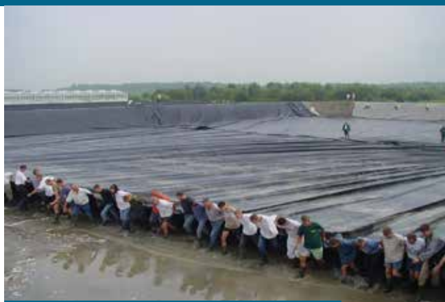
(Olanda, 2013) La stesura dei teli impermeabili per la creazione di laghi artificiali richiede, durante la fase di tiraggio, circa un manovale ogni 40 Kg. e/o un manovale ogni 2 metri di larghezza. Ecco perché, come è possibile vedere nella foto, per i grandi laghi è richiesto l'ausilio di molte persone. Ciò nonostante, è comunque spesso più conveniente realizzare il telo in una sola pezza pre-saldata, per poter procedere alla stesura in un solo giorno, risparmiando così sulla manodopera specializzata e sui materiali per la saldatura in loco. Inoltre, la presaldatura in fabbrica è nettamente migliore, poiché la tenuta stagna viene verificata mediante un doppio controllo di qualità.
