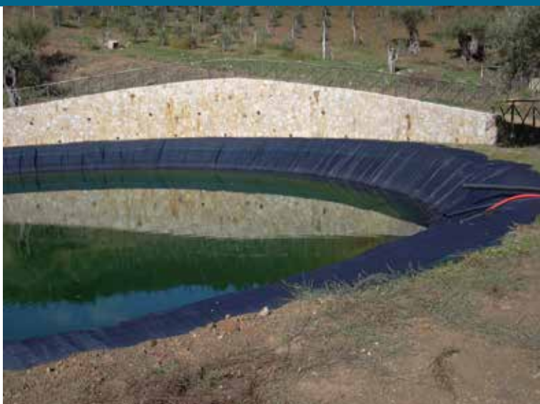
(Castelbuono, Sicilia, 2003) Il telo che si vede in questa foto non è quello impermeabile, bensì la rete di protezione delle sponde che favorisce il camminamento sui bordi nonché la fuoriuscita di animali selvatici e garantisce un'adeguata resistenza ai raggi UV.
