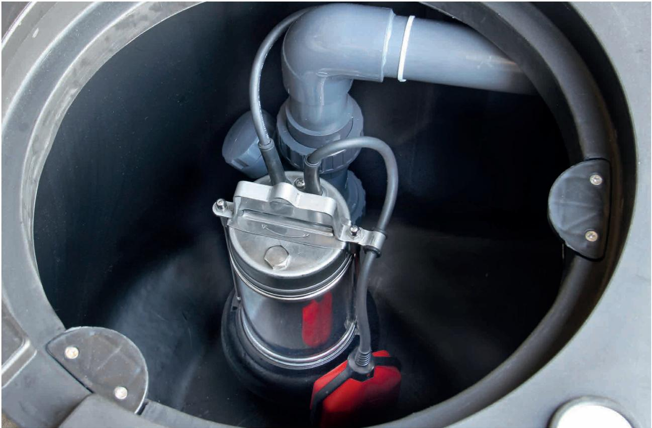
Stazione di sollevamento automatica per acque chiare e scure, costituita da un serbatoio da 100 l o 200 l predisposto per essere interrato in polietilene rinforzato.
